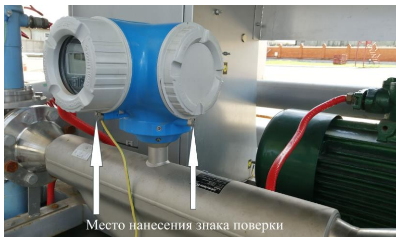
Рисунок 2 – Место и способы ограничения доступа к местам настройки и регулировки расходомера массового Promass
