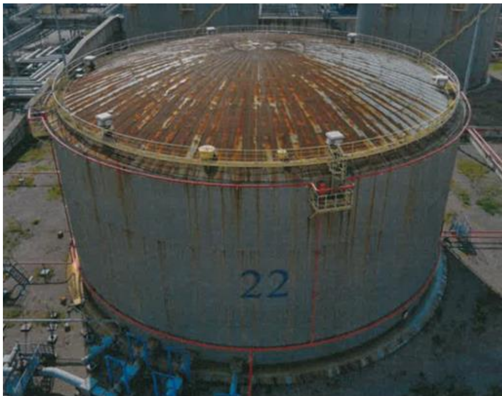
Рисунок 5 – Общий вид резервуара РВС-20000 зав. № 22
