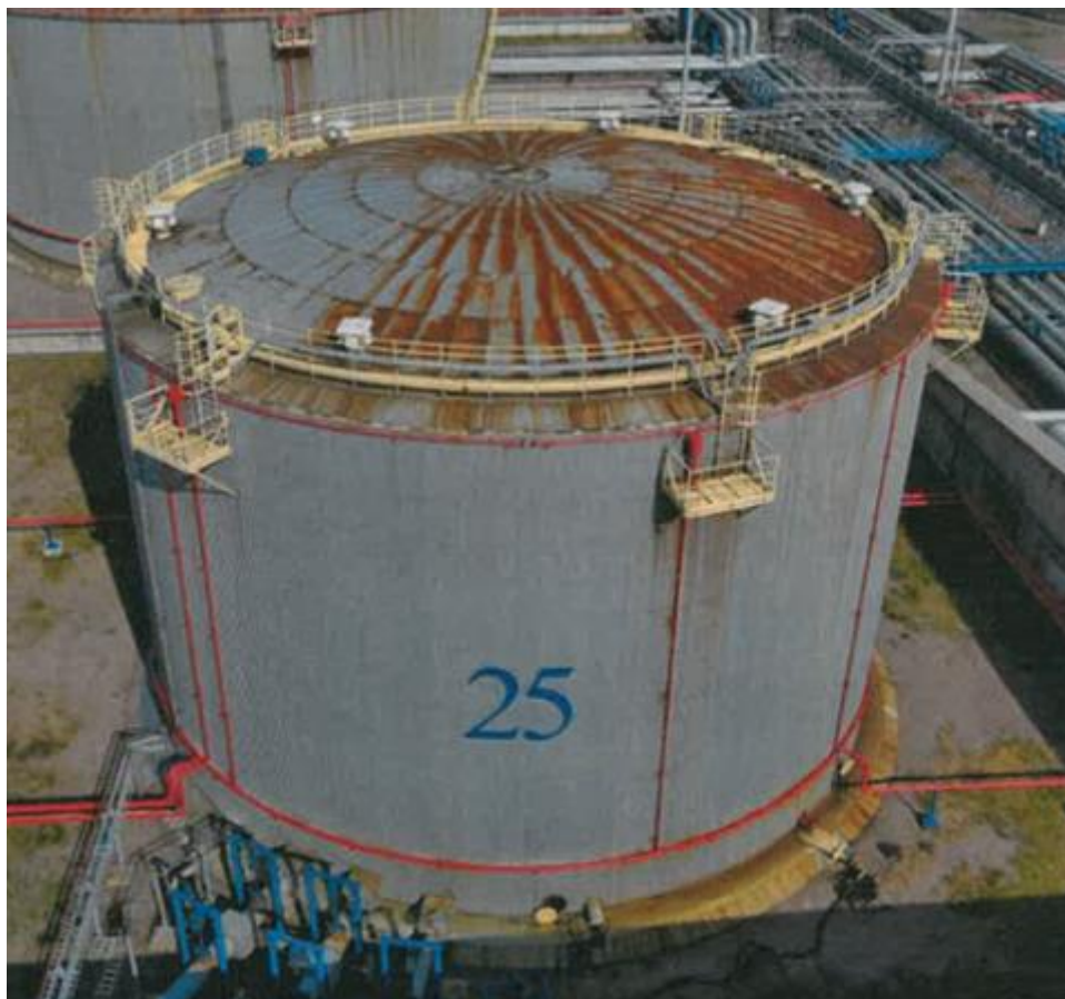
Рисунок 3 – Общий вид резервуара РВС-10000 зав. № 25
