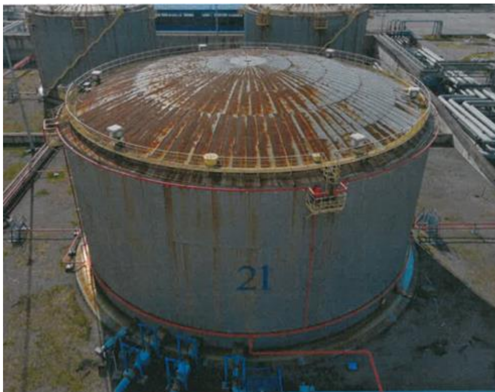
Рисунок 4 – Общий вид резервуара РВС-20000 зав. № 21
