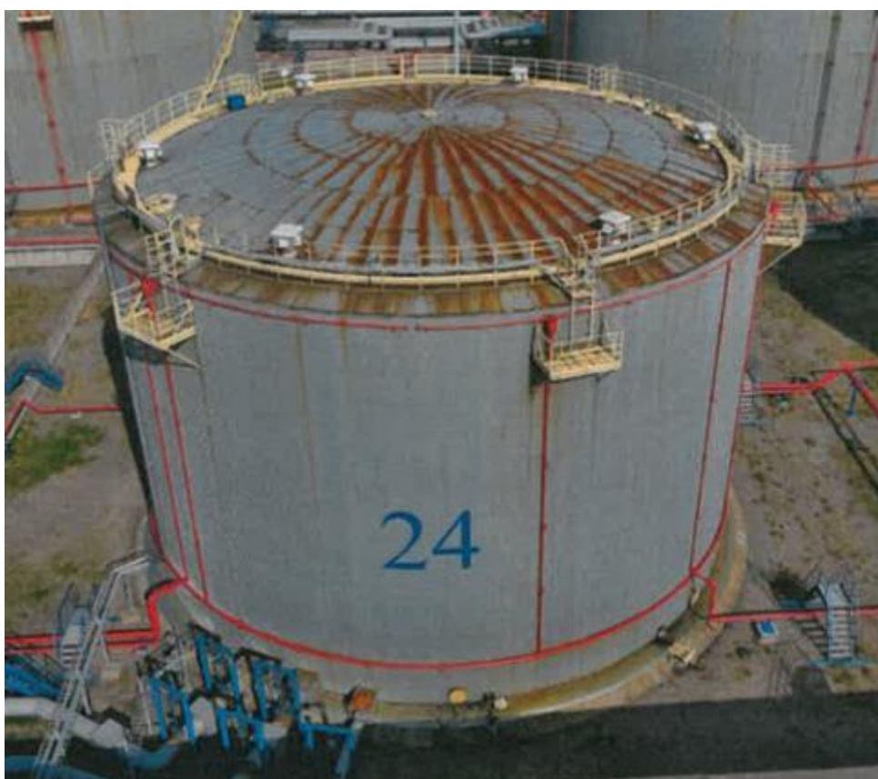
Рисунок 2 – Общий вид резервуара РВС-10000 зав. № 24
