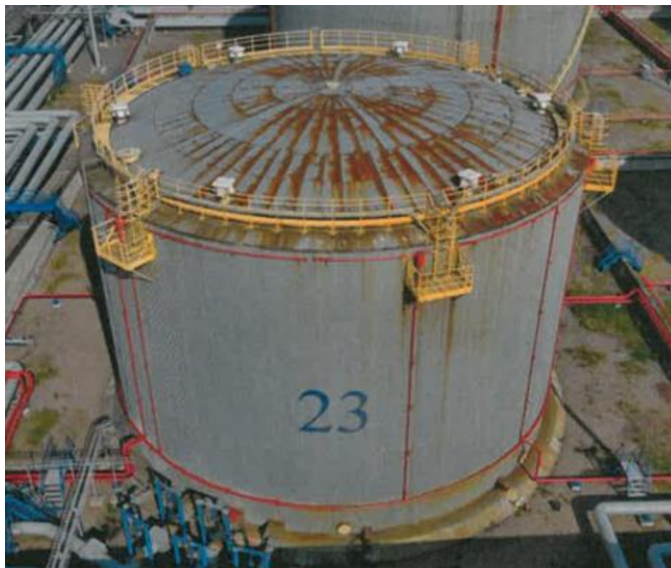
Рисунок 1 – Общий вид резервуара РВС-10000 зав. № 23
