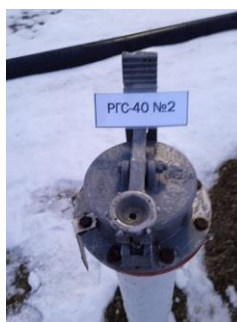
Рисунок 24 – Фотография горловины, замерного люка и заводского номера резервуара стального горизонтального цилиндрического РГС, модификации РГС-40 зав.№ 2
