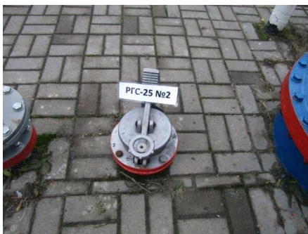
Рисунок 20 – Фотография горловины, замерного люка и заводского номера резервуара стального горизонтального цилиндрического РГС, модификации РГС-25 зав.№ 2
