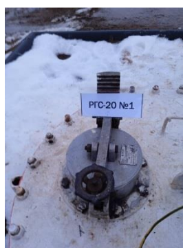
Рисунок 15 – Фотография горловины, замерного люка и заводского номера резервуара стального горизонтального цилиндрического РГС, модификации РГС-20 зав.№ 1
