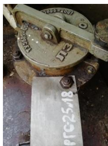
Рисунок 23 – Фотография горловины, замерного люка и заводского номера резервуара стального горизонтального цилиндрического РГС, модификации РГС-25 зав.№ 18
