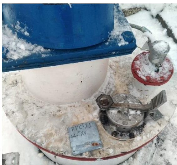
Рисунок 17 – Фотография горловины, замерного люка и заводского номера резервуара стального горизонтального цилиндрического РГС, модификации РГС-25 зав.№ XV
