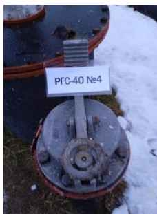
Рисунок 25 – Фотография горловины, замерного люка и заводского номера резервуара стального горизонтального цилиндрического РГС, модификации РГС-40 зав.№ 4
