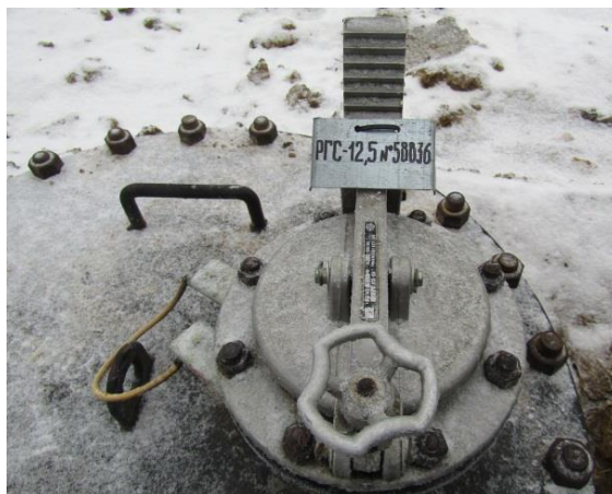
Рисунок 13 – Фотография горловины, замерного люка и заводского номера резервуара стального горизонтального цилиндрического РГС, модификации РГС-12,5 зав.№ 58836
