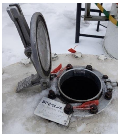
Рисунок 12 – Фотография горловины, замерного люка и заводского номера резервуара стального горизонтального цилиндрического РГС, модификации РГС-12 зав.№ 2
