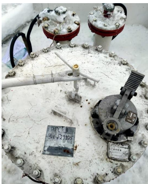
Рисунок 6 – Фотография горловины, замерного люка и заводского номера резервуара стального горизонтального цилиндрического РГС, модификации РГС-3 зав.№ 29105
