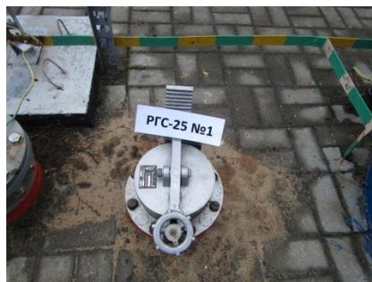
Рисунок 19 – Фотография горловины, замерного люка и заводского номера резервуара стального горизонтального цилиндрического РГС, модификации РГС-25 зав.№ 1 (расположен на территории НПС «Новозыбков»)
