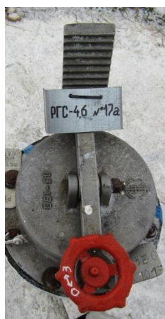
Рисунок 8 – Фотография горловины, замерного люка и заводского номера резервуара стального горизонтального цилиндрического РГС, модификации РГС-4,6 зав.№ 17а
