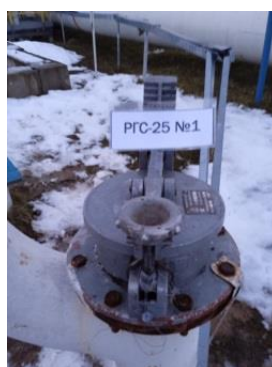
Рисунок 18 – Фотография горловины, замерного люка и заводского номера резервуара стального горизонтального цилиндрического РГС, модификации РГС-25 зав.№ 1 (расположен на территории ЛПДС «Унеча»)
