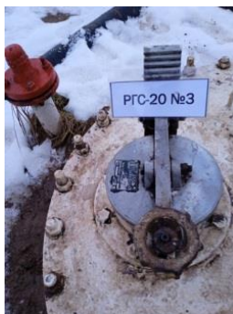
Рисунок 16 – Фотография горловины, замерного люка и заводского номера резервуара стального горизонтального цилиндрического РГС, модификации РГС-20 зав.№ 3
