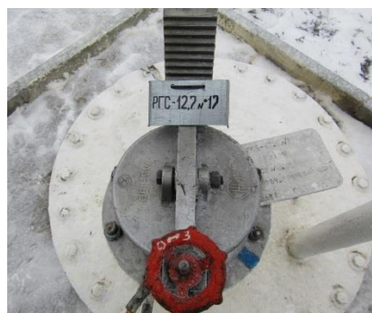
Рисунок 14 – Фотография горловины, замерного люка и заводского номера резервуара стального горизонтального цилиндрического РГС, модификации РГС-12,7 зав.№ 17
