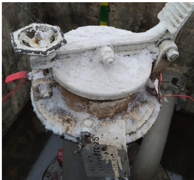
Рисунок 22 – Фотография горловины, замерного люка и заводского номера резервуара стального горизонтального цилиндрического РГС, модификации РГС-25 зав.№ 3 (расположен на территории ЛПДС «8Н»)
