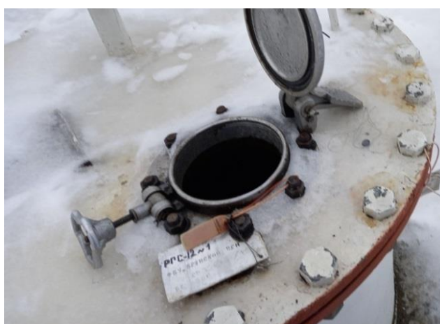
Рисунок 11 – Фотография горловины, замерного люка и заводского номера резервуара стального горизонтального цилиндрического РГС, модификации РГС-12 зав.№ 1
