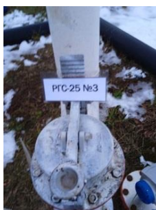
Рисунок 21 – Фотография горловины, замерного люка и заводского номера резервуара стального горизонтального цилиндрического РГС, модификации РГС-25 зав.№ 3 (расположен на территории ЛПДС «Унеча»)
