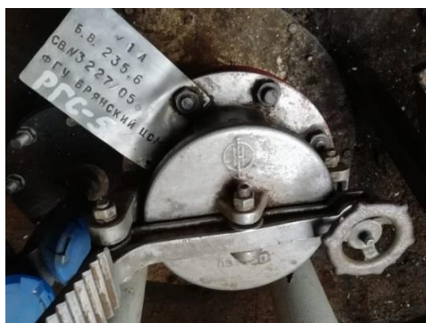
Рисунок 9 – Фотография горловины, замерного люка и заводского номера резервуара стального горизонтального цилиндрического РГС, модификации РГС-5 зав.№ 1А
