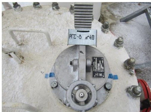
Рисунок 10 – Фотография горловины, замерного люка и заводского номера резервуара стального горизонтального цилиндрического РГС, модификации РГС-8 зав.№ 40
