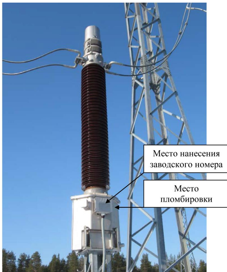
Рисунок 1 – Общий вид средства измерений с указанием места пломбировки, места нанесения заводского номера
