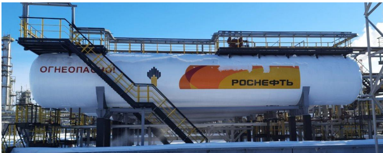
Рисунок 1 – Общий вид резервуаров
