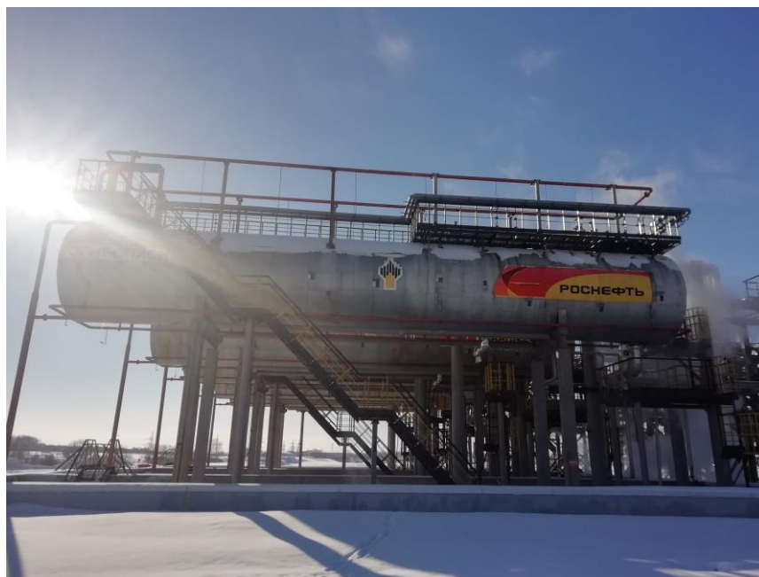
Рисунок 1 – Общий вид резервуаров РГС-200
