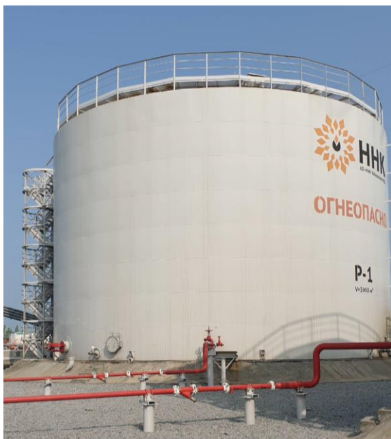
Рисунок 1 – Общий вид резервуара с зав. № 1
