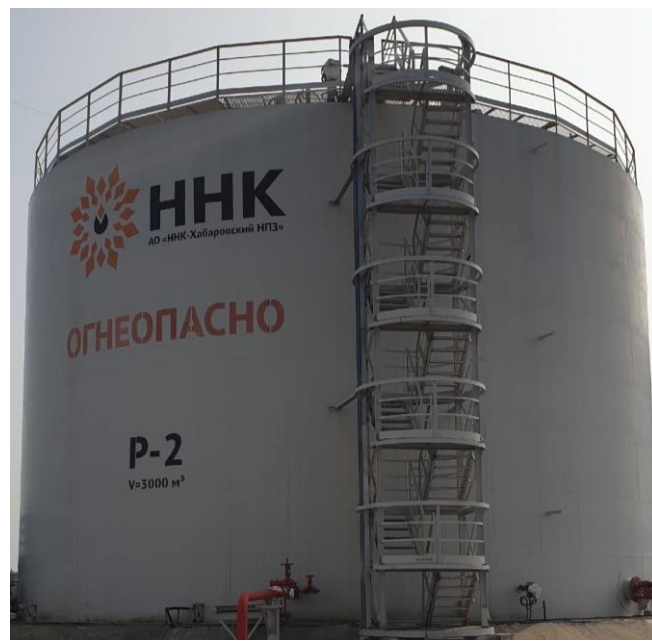
Рисунок 2 – Общий вид резервуара с зав. № 2
