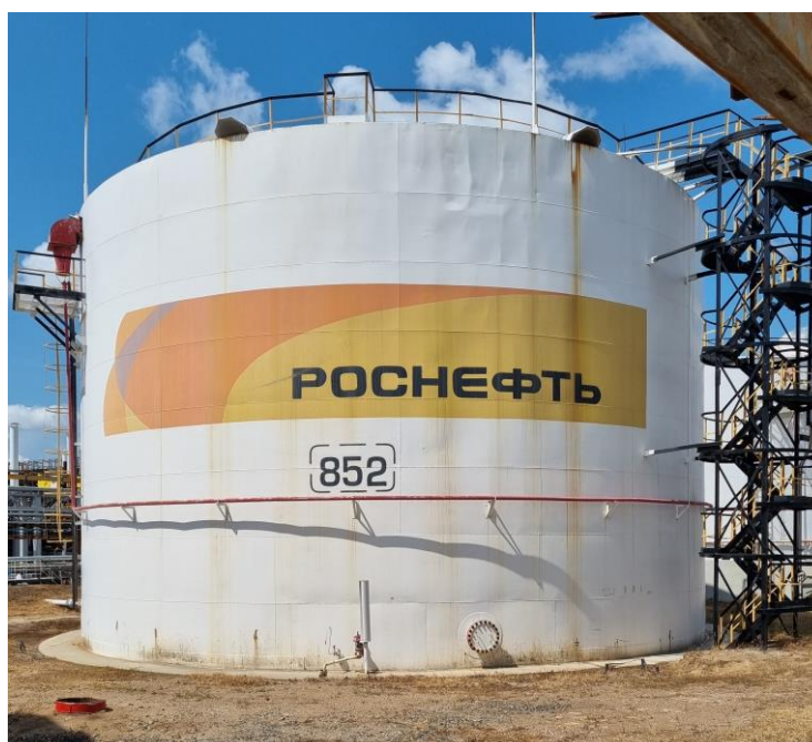
Рисунок 5 – Общий вид резервуаров РВС-3000
