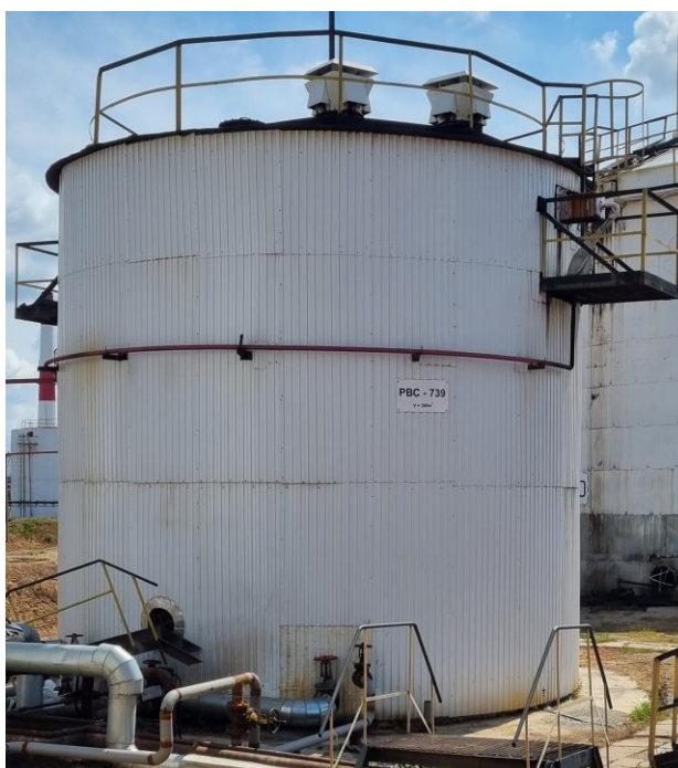
Рисунок 1 – Общий вид резервуара РВС-300
