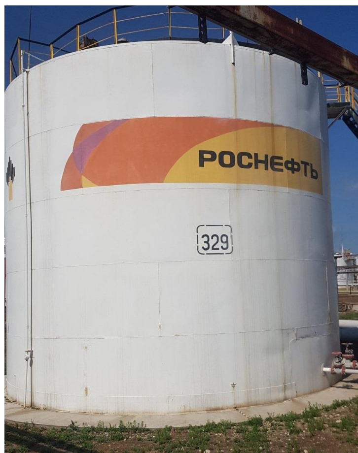
Рисунок 3 – Общий вид резервуара РВС-1000
