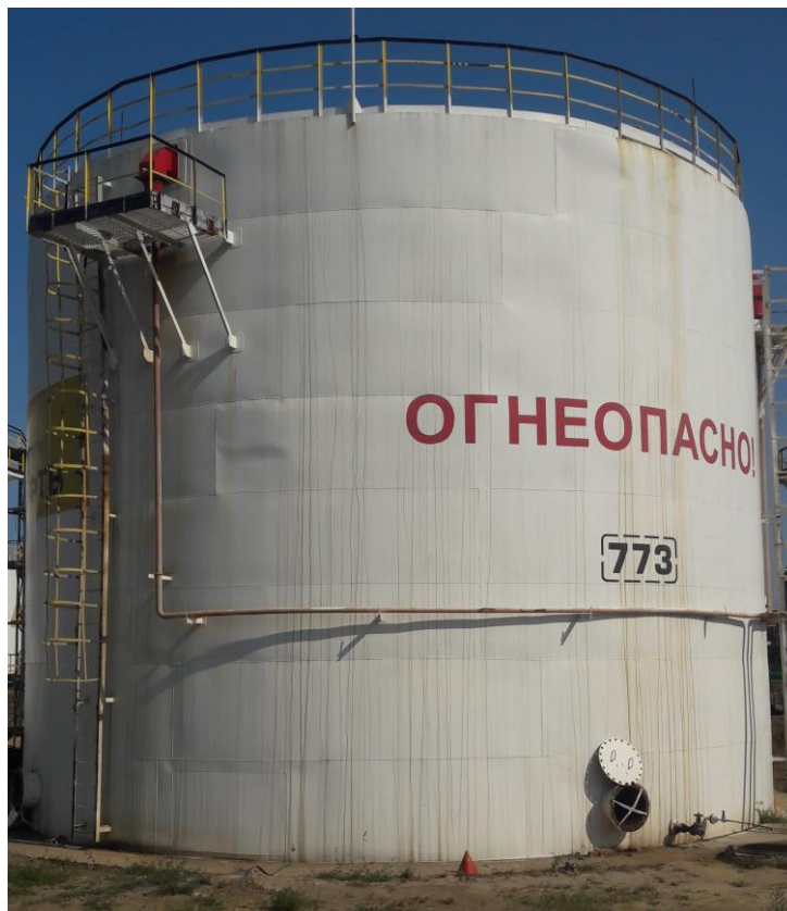
Рисунок 4 – Общий вид резервуаров РВС-2000
