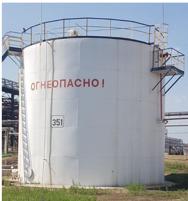
Рисунок 2 – Общий вид резервуара РВС-700
