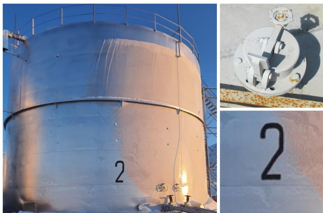
Рисунок 2 – Общий вид резервуара РВС-1000 с заводским номером 2
