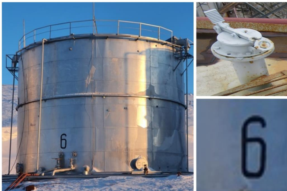
Рисунок 5 – Общий вид резервуара РВС-1000 с заводским номером 6
