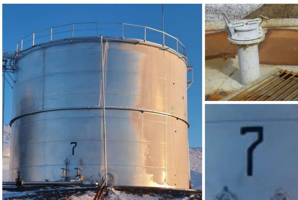
Рисунок 6 – Общий вид резервуара РВС-1000 с заводским номером 7
