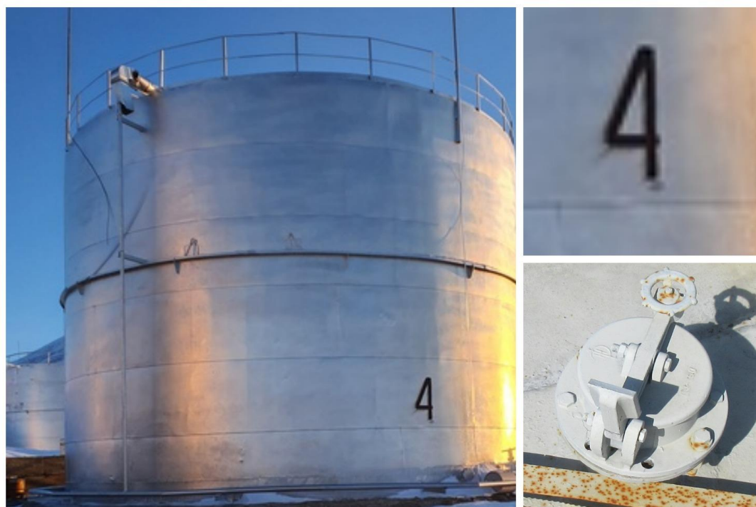
Рисунок 4 – Общий вид резервуара РВС-1000 с заводским номером 4
