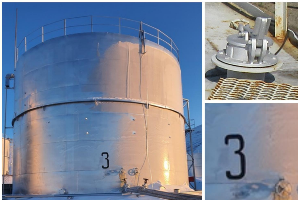
Рисунок 3 – Общий вид резервуара РВС-1000 с заводским номером 3
