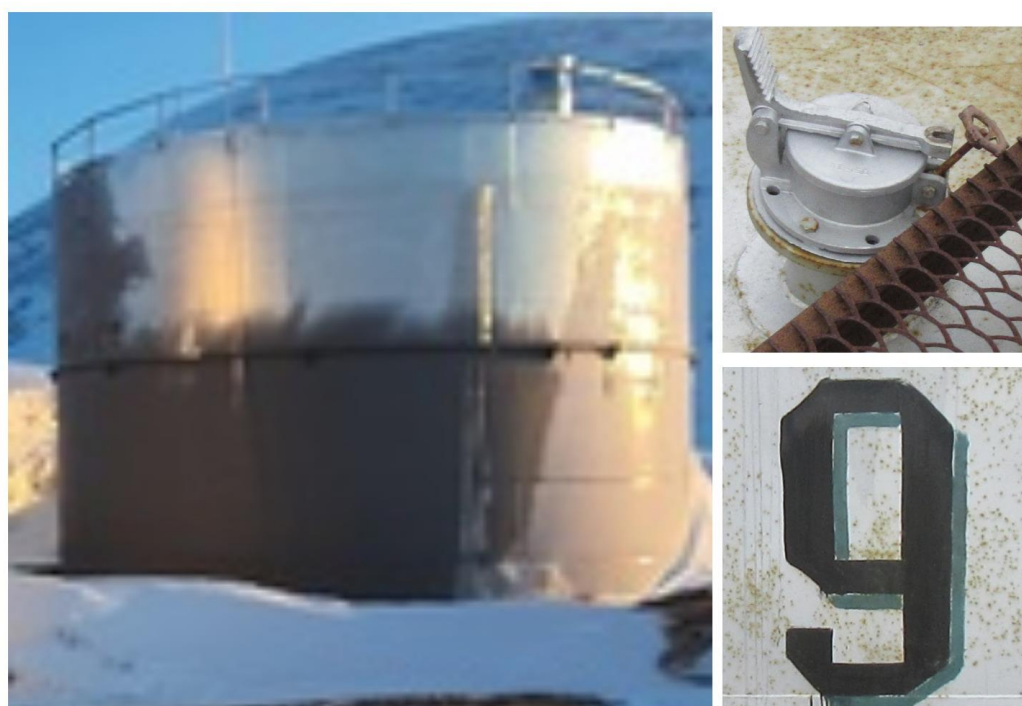
Рисунок 8 – Общий вид резервуара РВС-1000 с заводским номером 9
