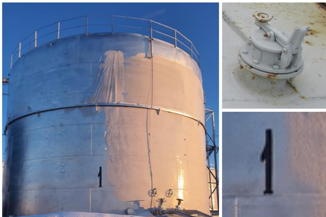
Рисунок 1 – Общий вид резервуара РВС-1000 с заводским номером 1
