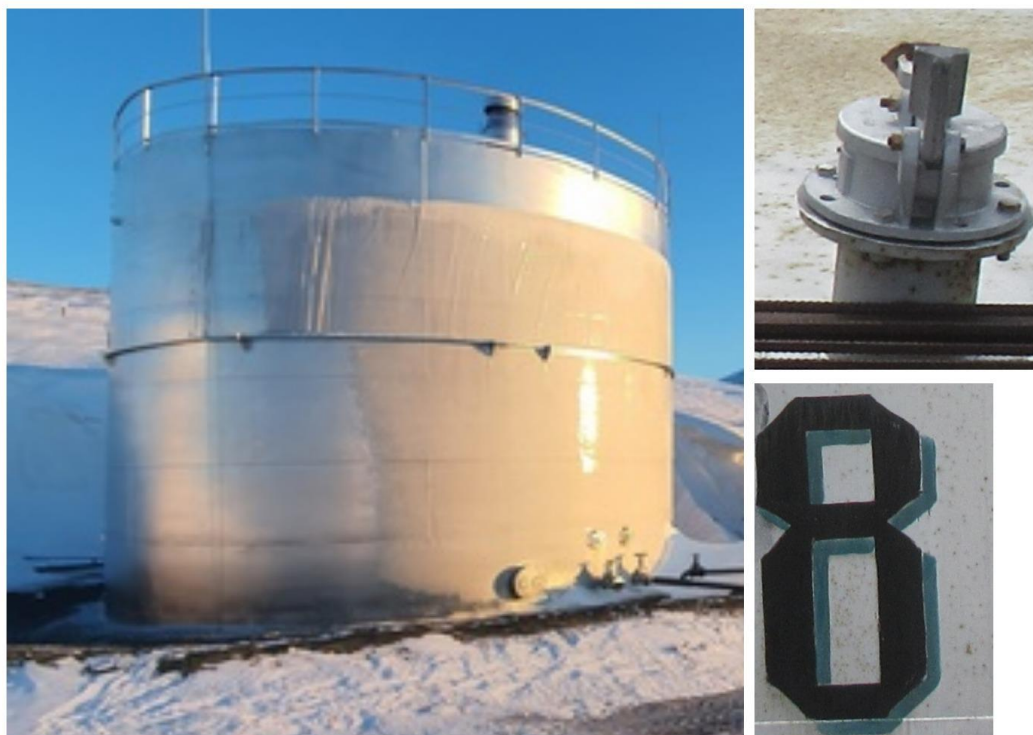
Рисунок 7 – Общий вид резервуара РВС-1000 с заводским номером 8
