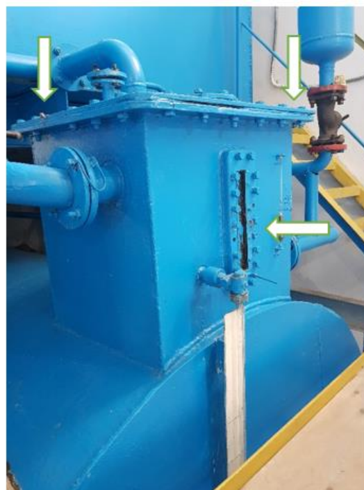
Рисунок 5 – Схема пломбировки мерника ММГ-1000У, зав.№ 60, от несанкционированного доступа, обозначение места нанесения знака поверки
