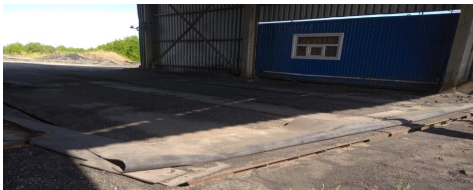
Рисунок 3 - Общий вид ГПУ весов, установленных на щебеночное основание
