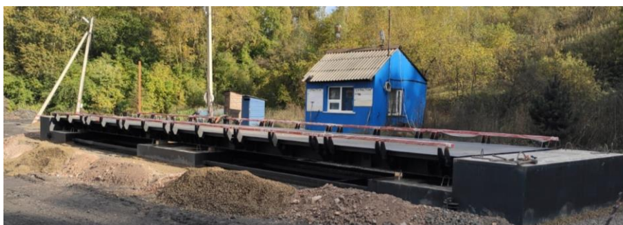
Рисунок 2 - Общий вид ГПУ весов, установленных на щебеночное основание
