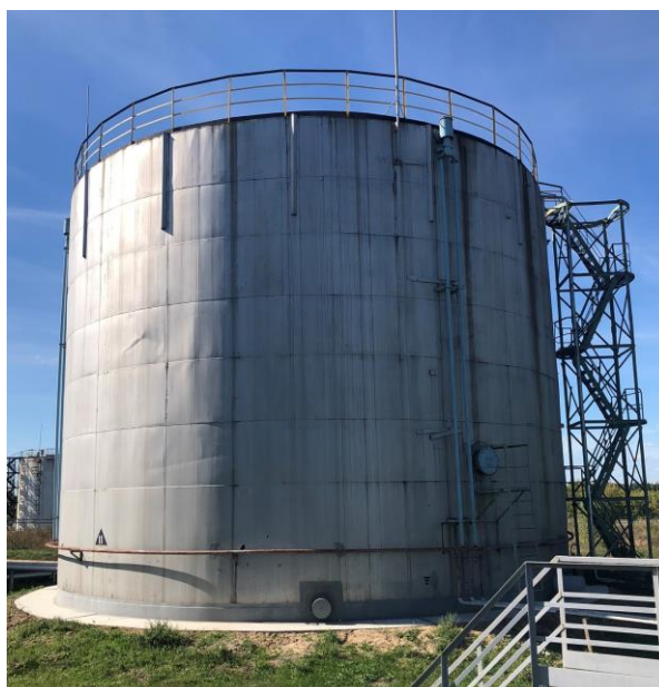
Рисунок 1 – Общий вид резервуаров РВС-2000
