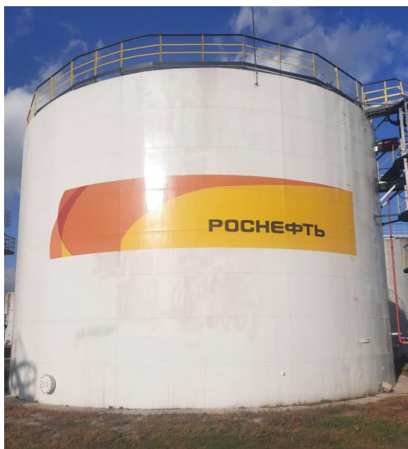
Рисунок 1 – Общий вид резервуаров РВС-3000
