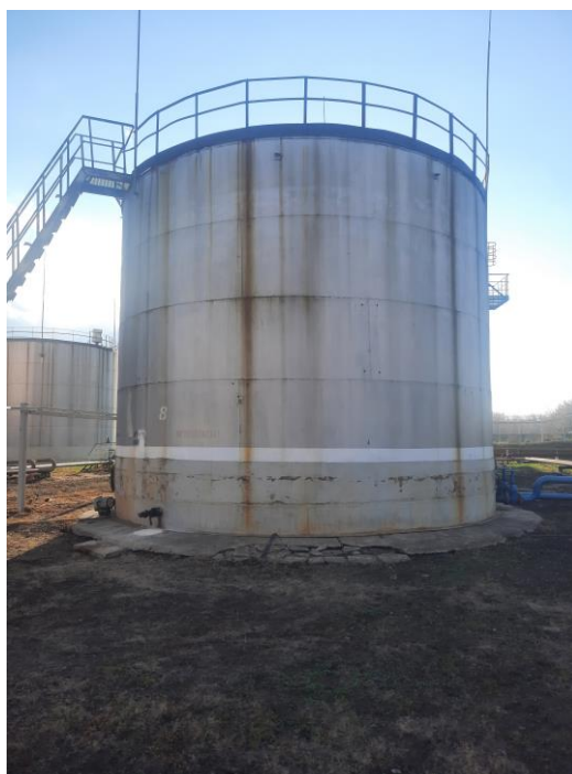
Рисунок 1 – Общий вид резервуара РВС-400
