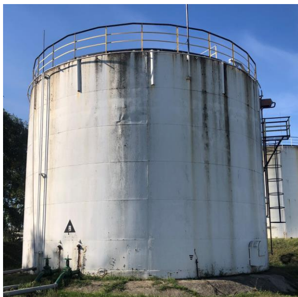
Рисунок 1 – Общий вид резервуаров РВСП-1000
