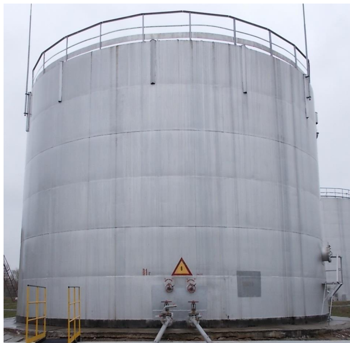
Рисунок 2 – Общий вид резервуаров РВСП-1000
