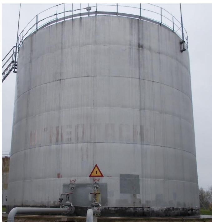
Рисунок 1 – Общий вид резервуаров РВСП-700
