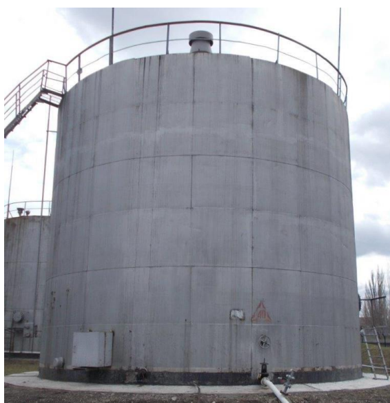
Рисунок 1 – Общий вид резервуаров РВСП-700
