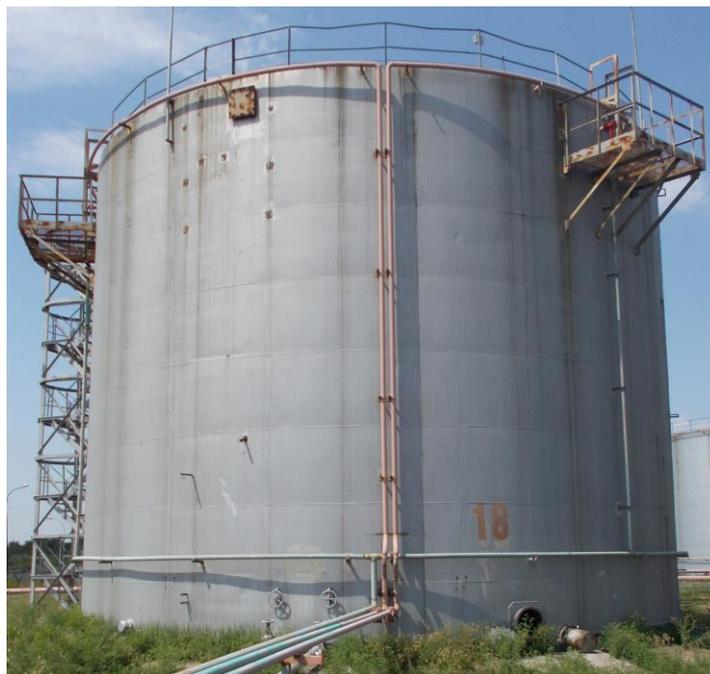
Рисунок 2 – Общий вид резервуаров РВС-2000
