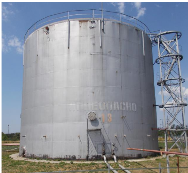
Рисунок 2 – Общий вид резервуаров РВСП-2000
