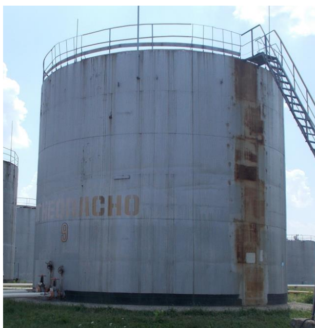
Рисунок 1 – Общий вид резервуаров РВСП-700
