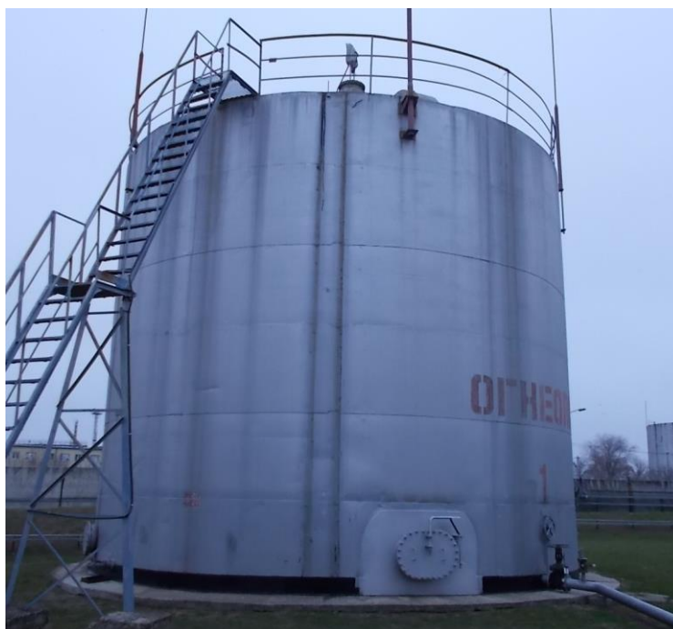
Рисунок 1 – Общий вид резервуаров РВСП-700
