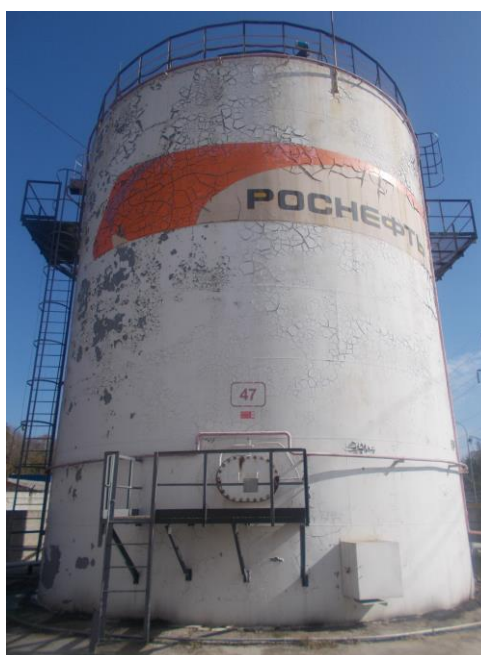
Рисунок 1 – Общий вид резервуаров РВСП-1000
