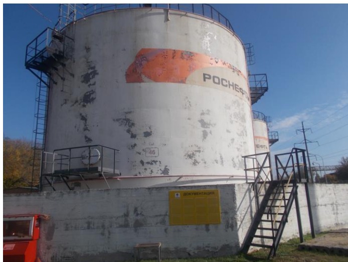
Рисунок 2 – Общий вид резервуаров РВСП-2000
