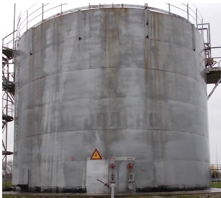
Рисунок 1 – Общий вид резервуара РВС-1000
