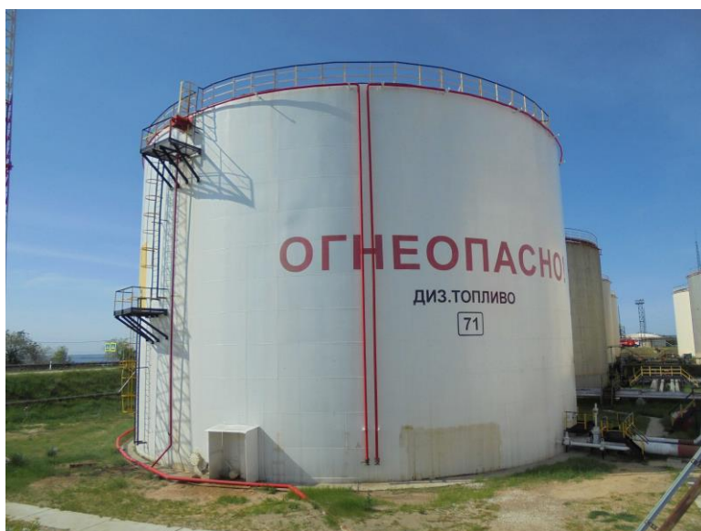
Рисунок 3 – Общий вид резервуаров РВС-10000
