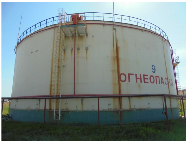
Рисунок 2 – Общий вид резервуара РВС-8000
