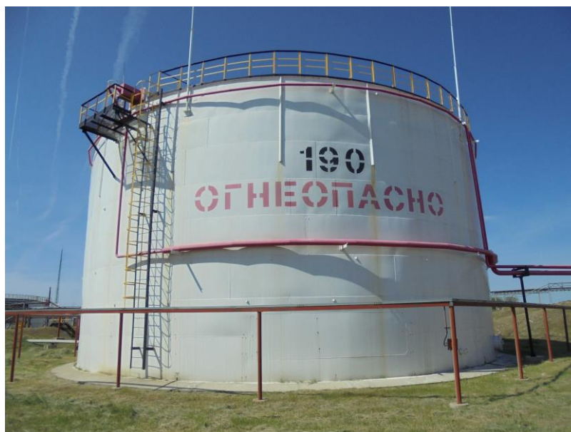
Рисунок 1 – Общий вид резервуара РВС-5000
