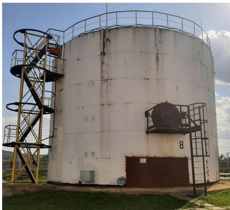
Рисунок 1 – Общий вид резервуара РВСП-1000
