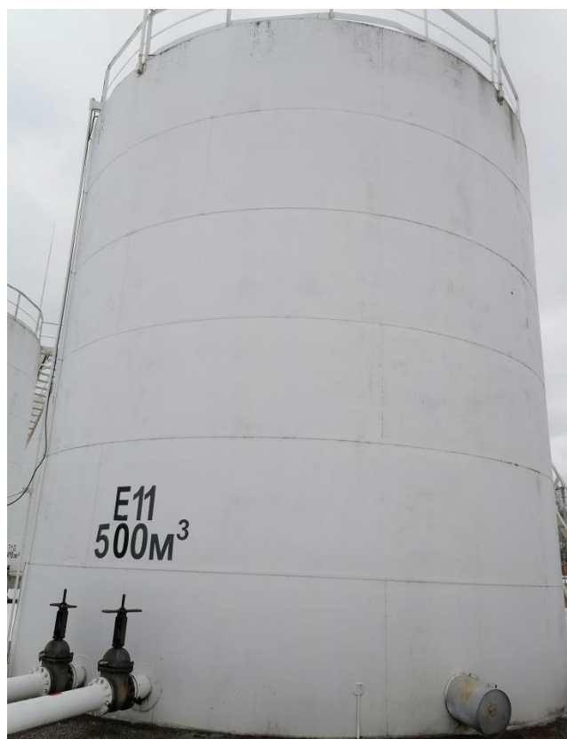
Рисунок 2 – Общий вид резервуара РВС-500 зав.№ E11
