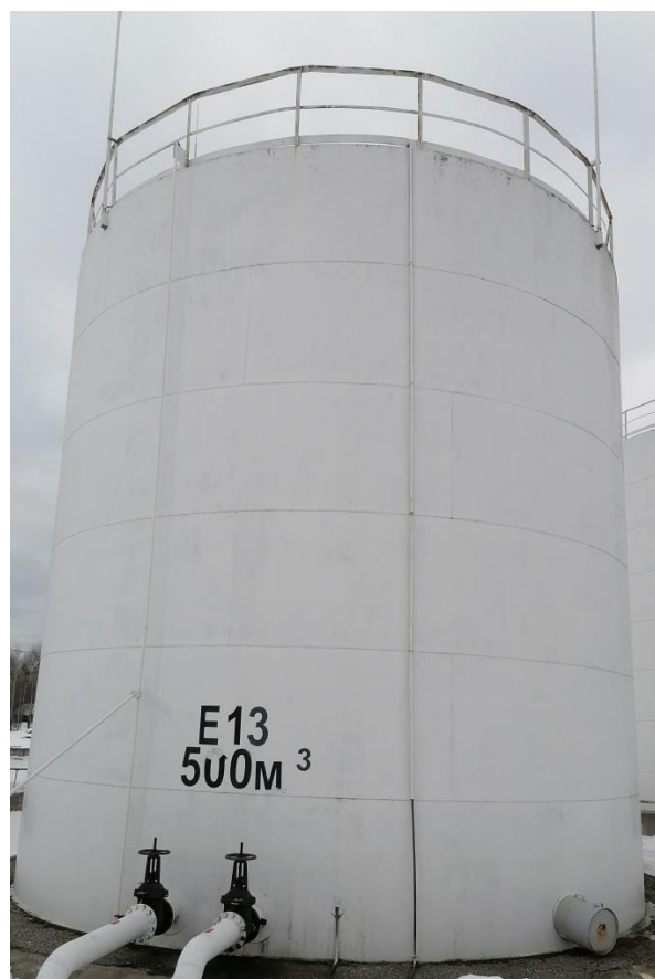
Рисунок 4 – Общий вид резервуара РВС-500 зав.№ E13
