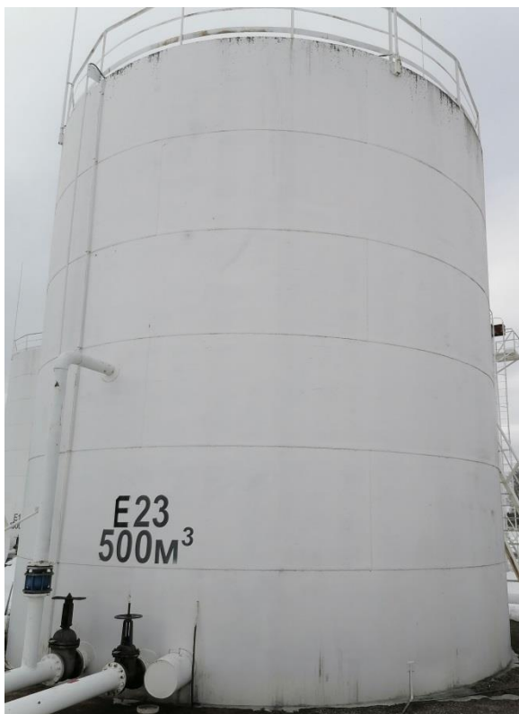
Рисунок 5 – Общий вид резервуара РВС-500 зав.№ E23
