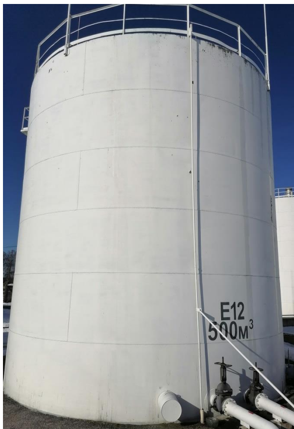
Рисунок 3 – Общий вид резервуара РВС-500 зав.№ E12
