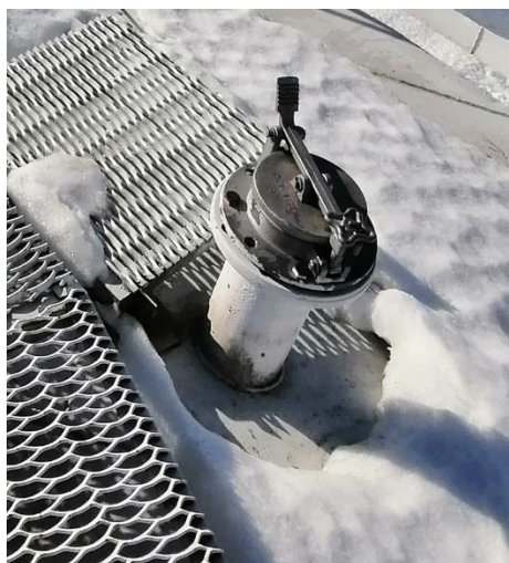
Рисунок 6 – Фото замерного люка резервуаров РВС-500
