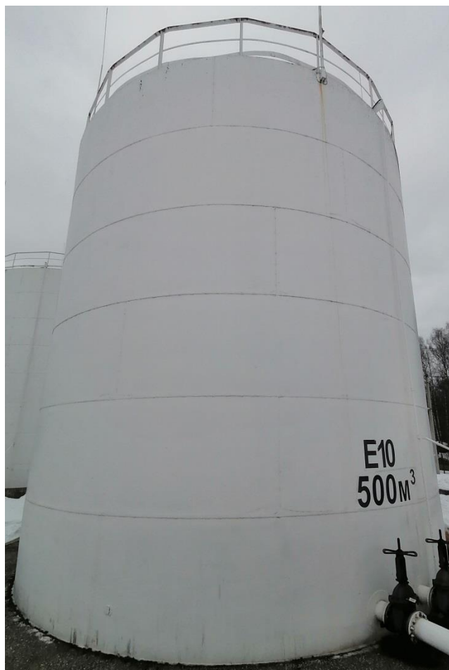
Рисунок 1 – Общий вид резервуара РВС-500 зав.№ E10
