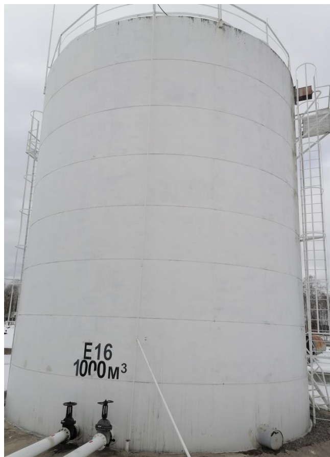
Рисунок 3 – Общий вид резервуара РВС-1000 зав.№ E16
