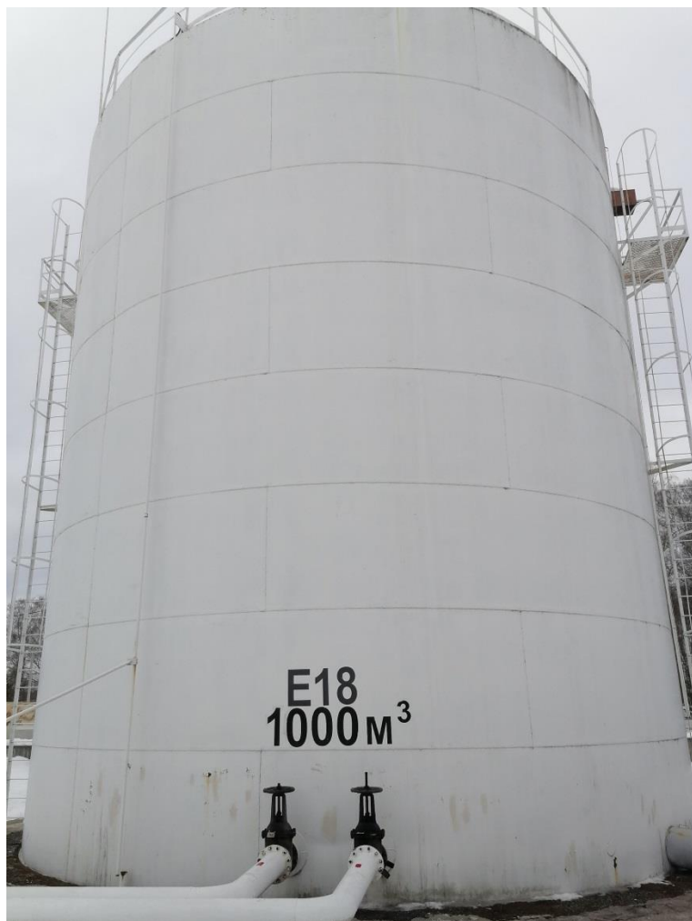
Рисунок 5 – Общий вид резервуара РВС-1000 зав.№ E18
