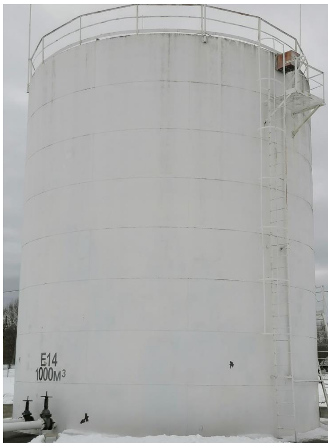
Рисунок 1 – Общий вид резервуара РВС-1000 зав.№ E14
