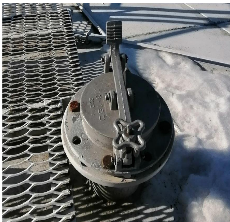
Рисунок 6 – Фото замерного люка резервуаров РВС-1000
