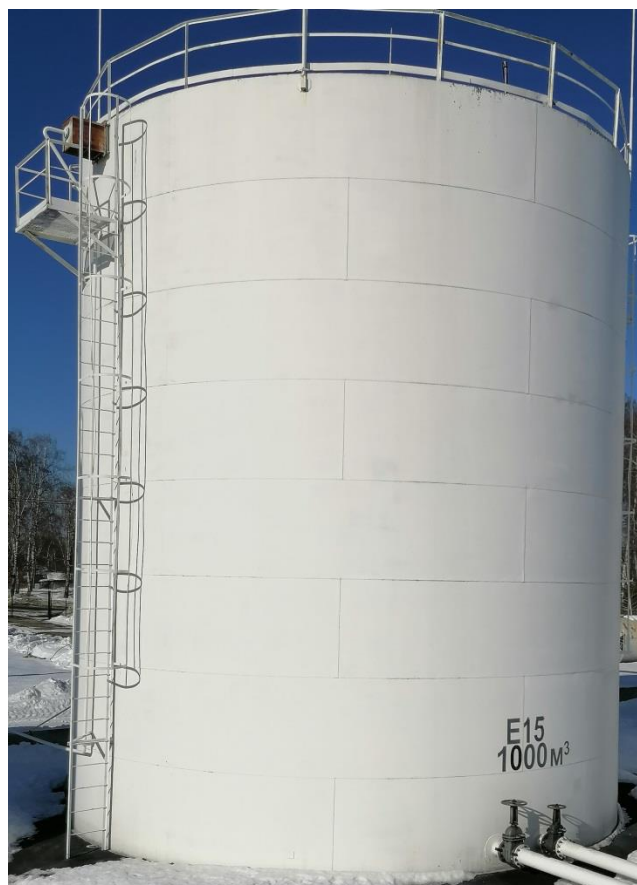
Рисунок 2 – Общий вид резервуара РВС-1000 зав.№ E15
