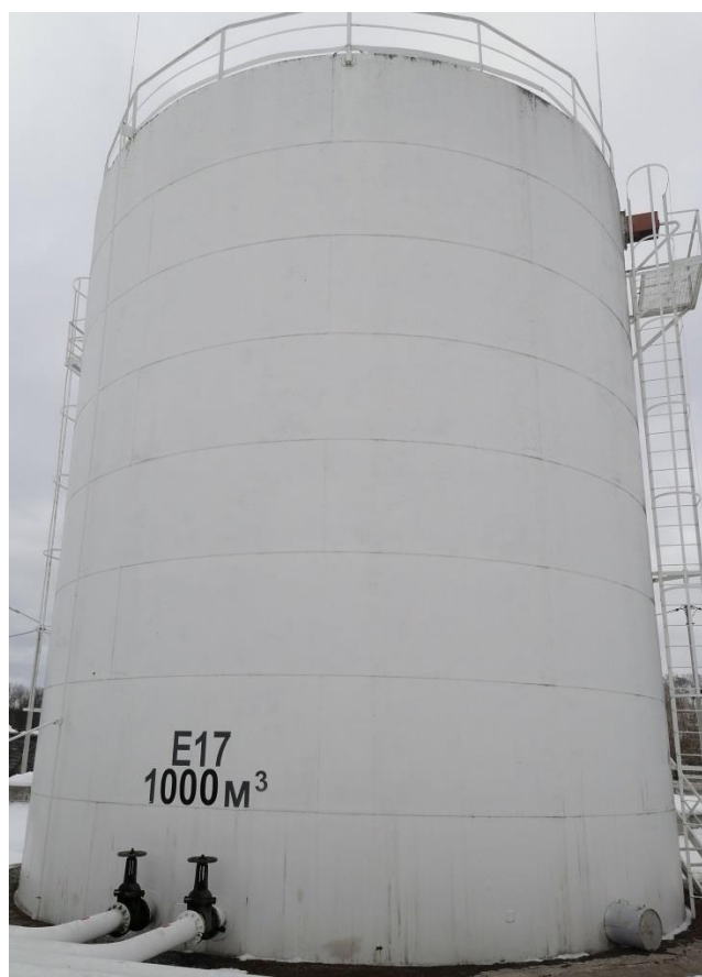
Рисунок 4 – Общий вид резервуара РВС-1000 зав.№ E17
