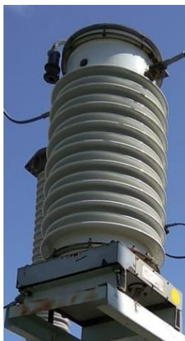
Рисунок 1 – Общий вид трансформаторов тока ТФЗМ 110Б
