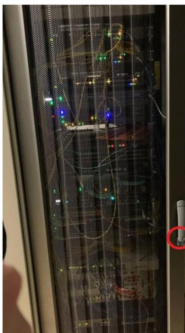
Рисунок 3 – Место блокировки от несанкционированного доступа к стойке с оборудованием
