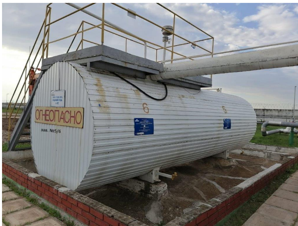
Рисунок 2 – Общий вид резервуара РГС-20 с заводским номером 5/6
