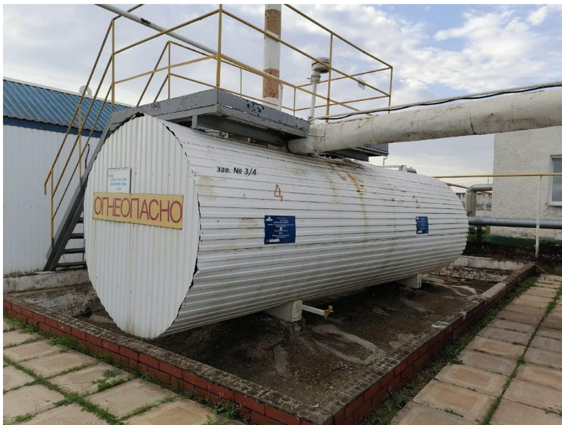
Рисунок 1 – Общий вид резервуара РГС-20 с заводским номером 3/4
