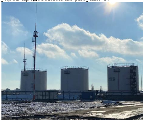
Рисунок 1 - Общий вид резервуаров.
