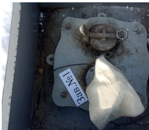
Рисунок 1 – Общий вид резервуара РГС-70
