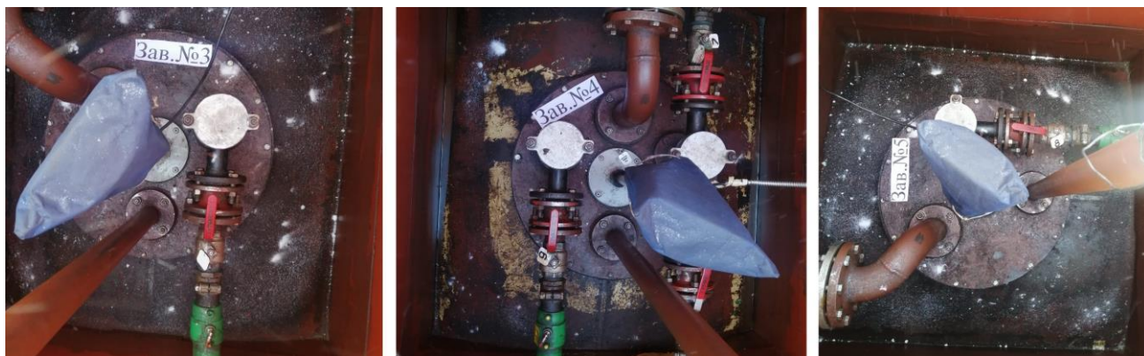
Рисунок 2 – Общий вид резервуаров РГС-60
