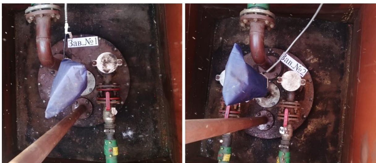
Рисунок 1 – Общий вид резервуаров РГС-60
