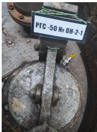
Рисунок 4 – Фотография горловины и заводского номера резервуара стального горизонтального цилиндрического РГС, модификации РГС-50, заводской номер ОН-2-1
