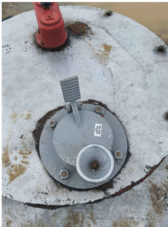
Рисунок 2 – Фото горловины и замерного люка резервуаров РГС-50
