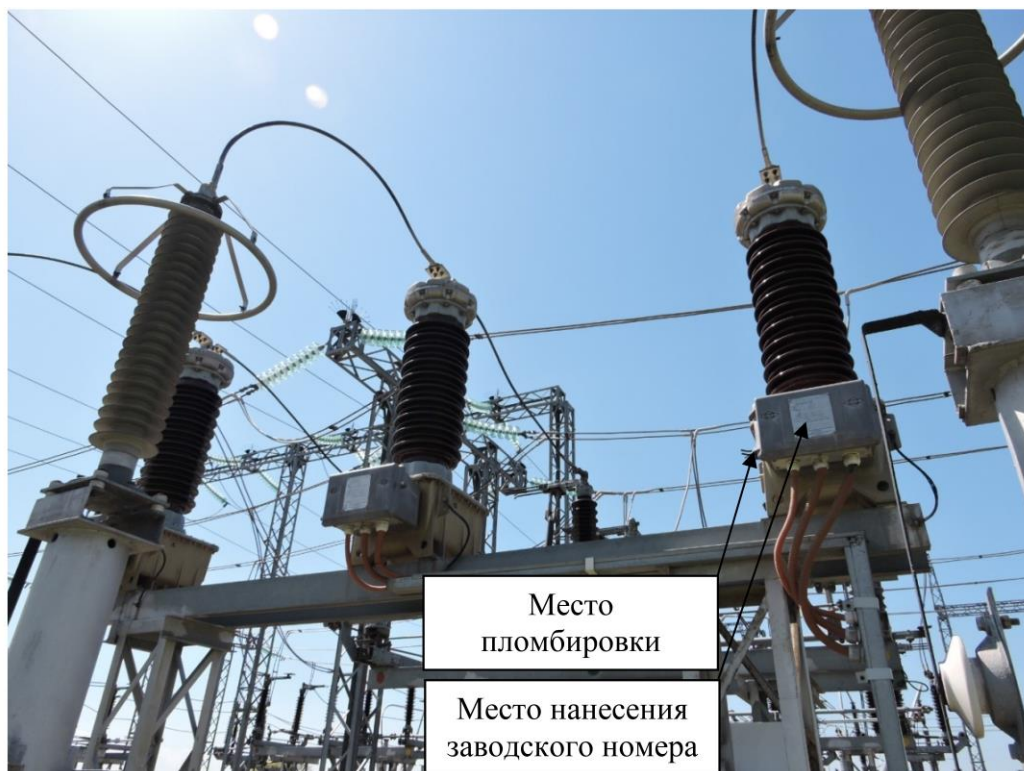
Рисунок 1. Общий вид средства измерений с указанием места пломбировки, места нанесения заводского номера
