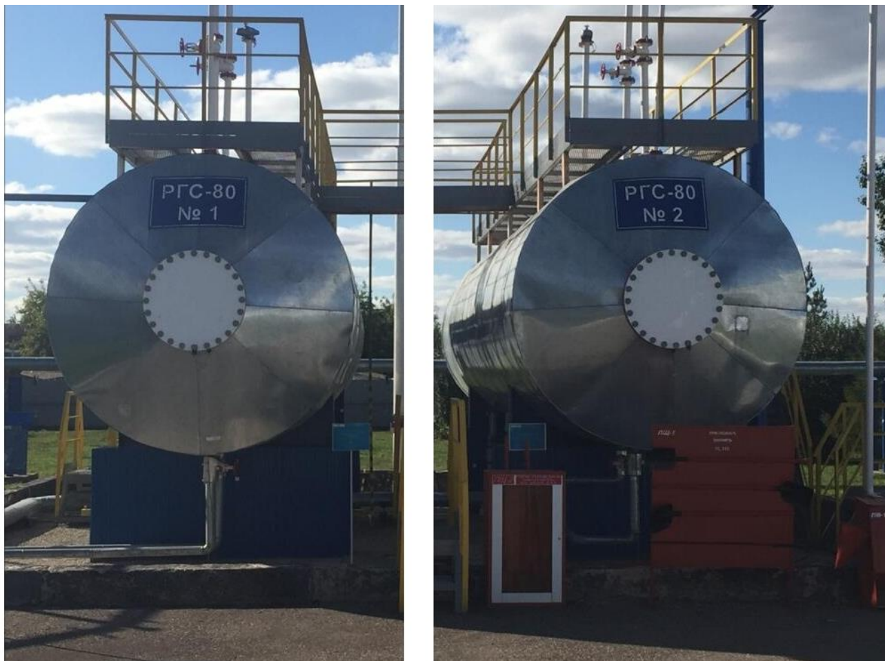
Рисунок 2 – Общий вид резервуаров РГС-80
