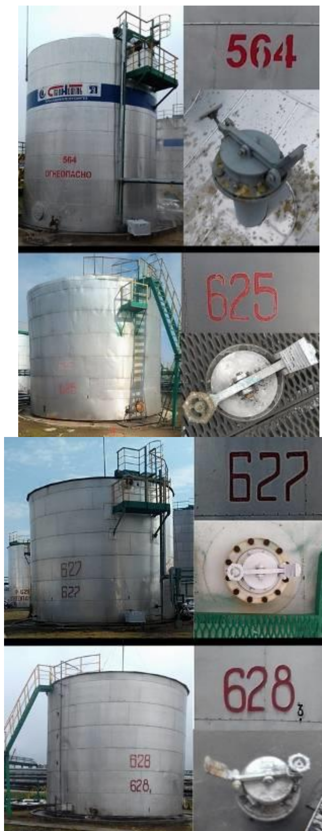
Рисунок 1 – Общий вид резервуаров стальных вертикальных цилиндрических РВС-400 №№ 564, 625, 627, 628 их горловин и заводских номеров
