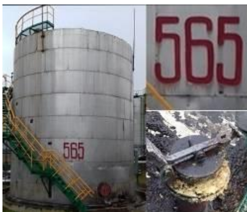
Рисунок 2 – Общий вид резервуара стального вертикального цилиндрического РВС-400 № 565 его горловины и заводского номера
