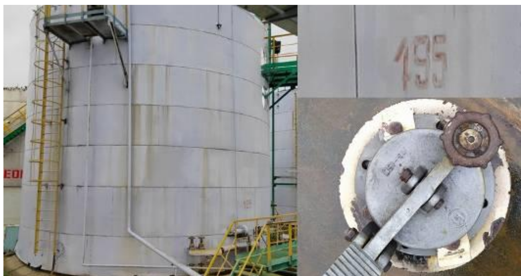
Рисунок 6– Общий вид резервуара стального вертикального цилиндрического РВС-700 №195 его горловины и заводского номера
