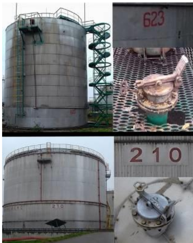
Рисунок 5 – Общий вид резервуаров стальных вертикальных цилиндрических РВС-1000 №623, РВС-10000 №210 их горловин и заводских номеров
