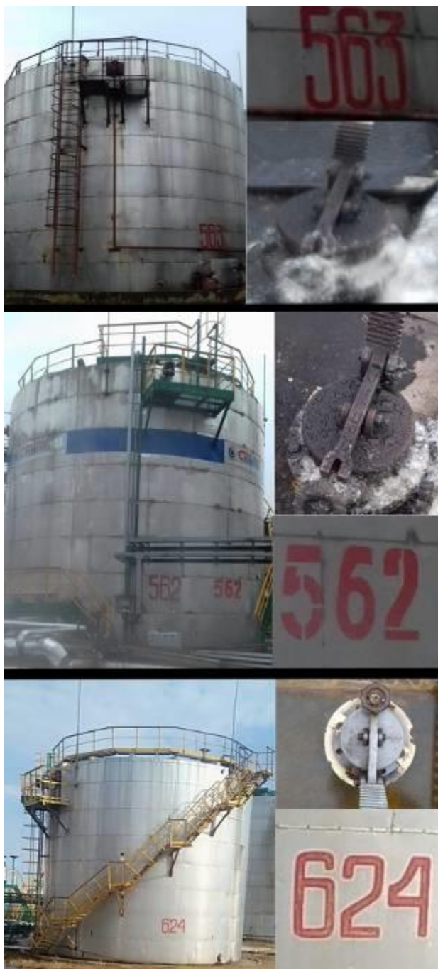
Рисунок 4 – Общий вид резервуаров стальных вертикальных цилиндрических РВС-700 №№ 562, 563, 624 их горловин и заводских номеров
