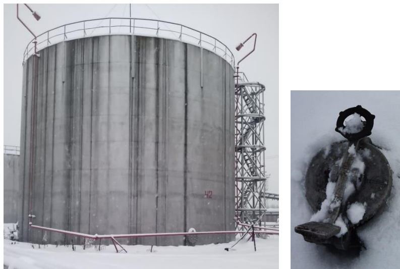
Рисунок 2 – Общий вид резервуара с заводским номером 42 и замерного люка
