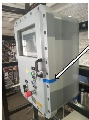
Рисунок 8 - Место нанесения пломбы на кон- троллер управления
