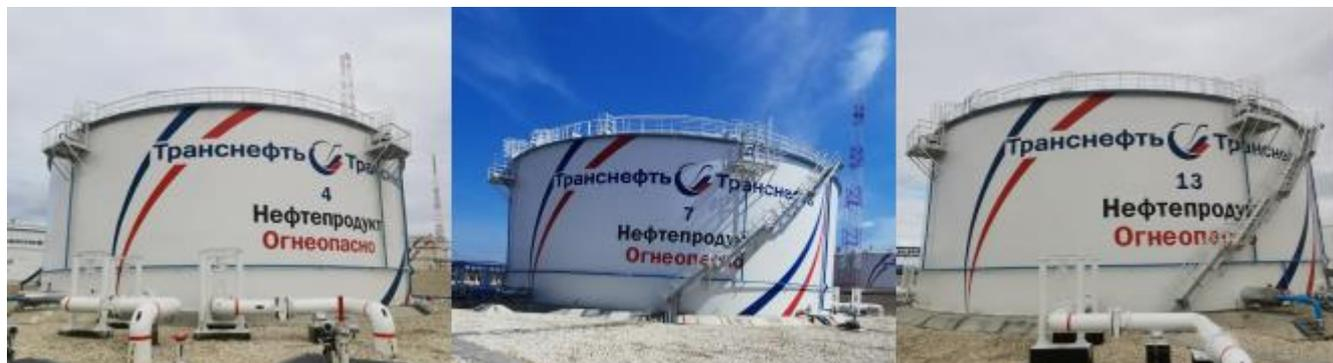
Рисунок 1 – Общий вид резервуаров стальных вертикальных цилиндрических РВС-10000
