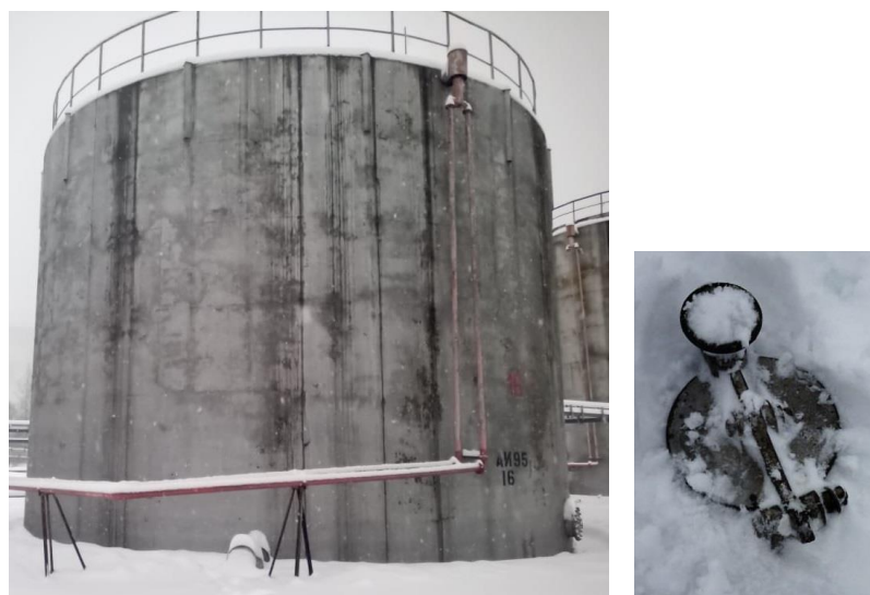
Рисунок 1 – Общий вид резервуара с заводским номером 16 и замерного люка
