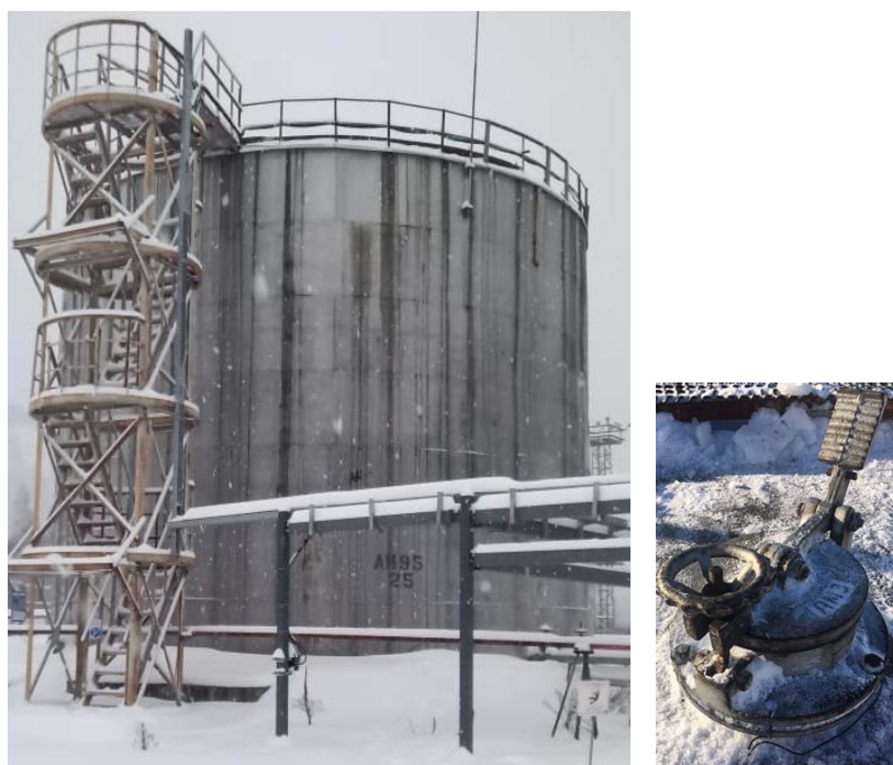
Рисунок 2 – Общий вид резервуара с заводским номером 25 и замерного люка
