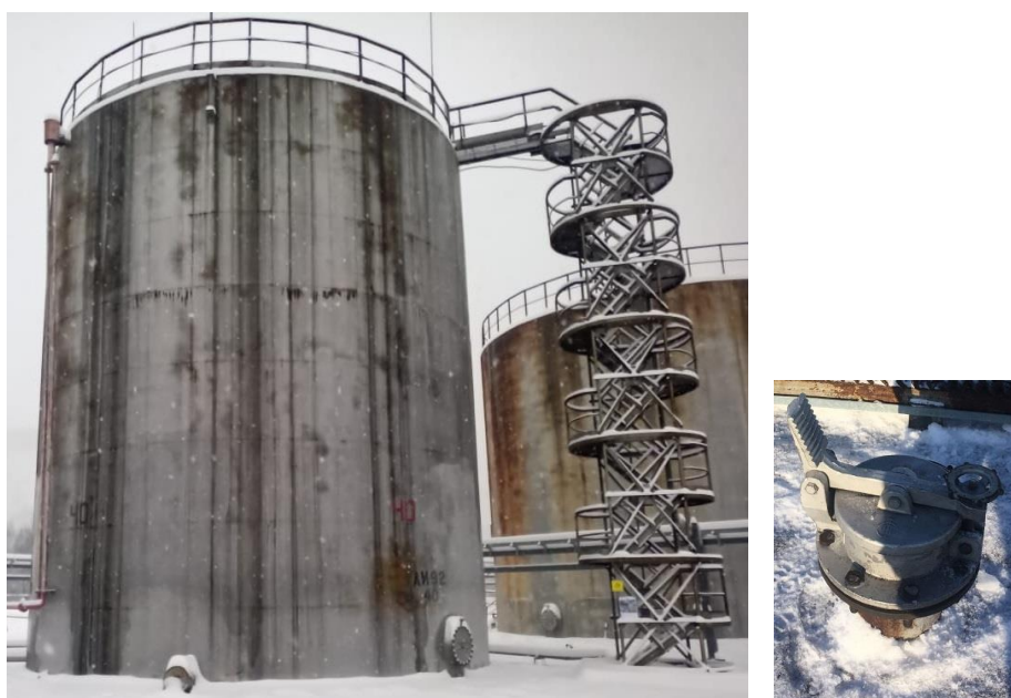
Рисунок 3 – Общий вид резервуара с заводским номером 40 и замерного люка
