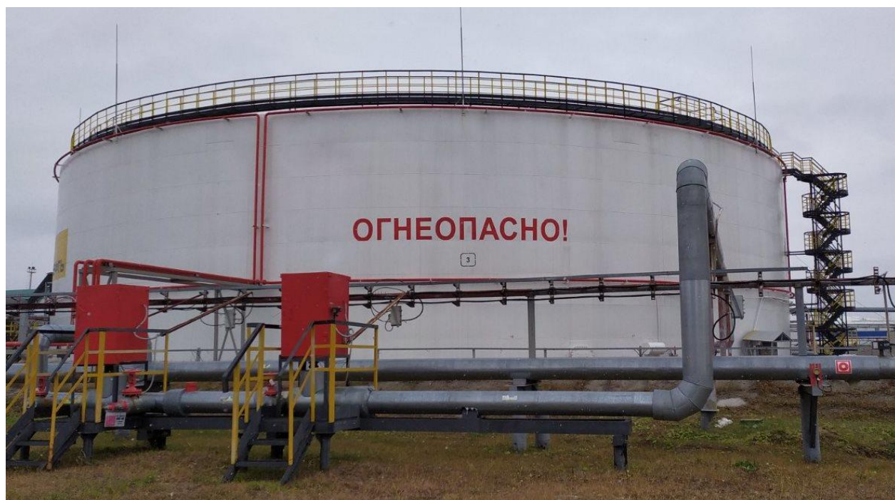
Рисунок 1 – Общий вид резервуаров РВС-20000
