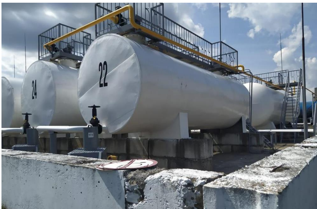
Рисунок 2 – Общий вид резервуаров РГС-25
