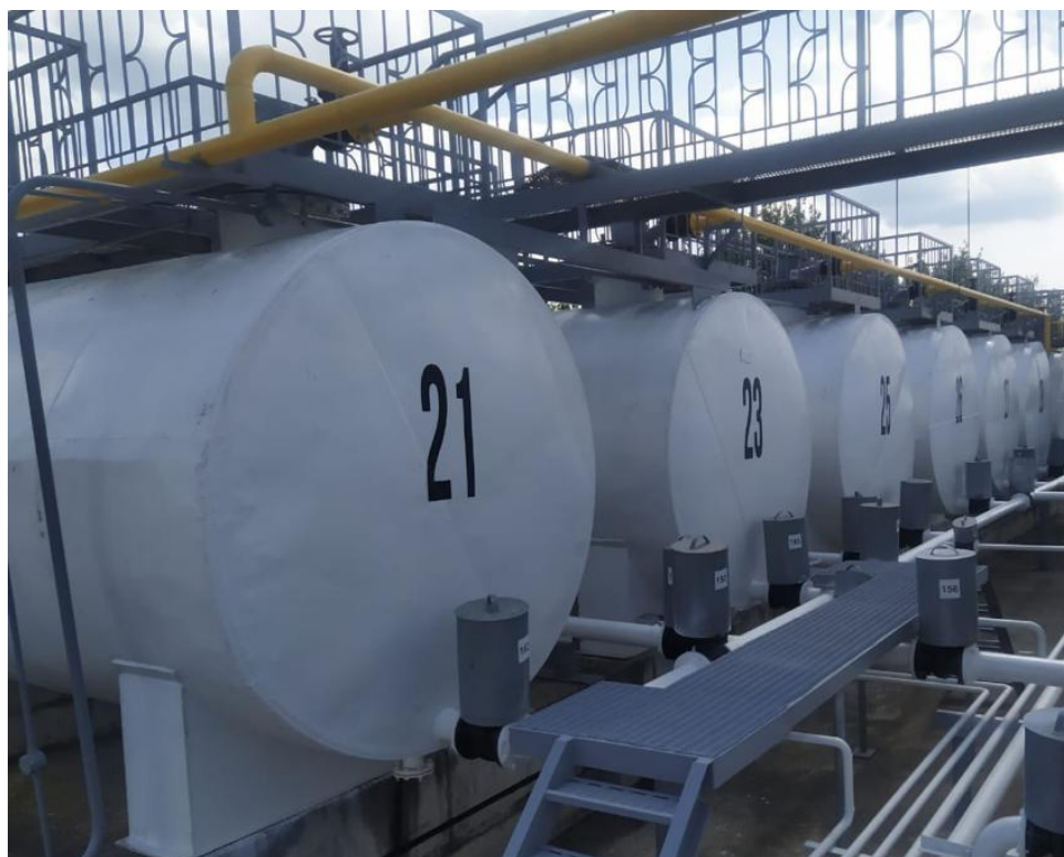
Рисунок 1 – Общий вид резервуаров РГС-25
