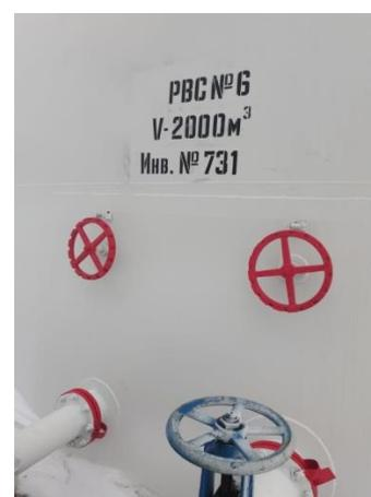
Рисунок 2 – Место нанесения заводского номера резервуара
