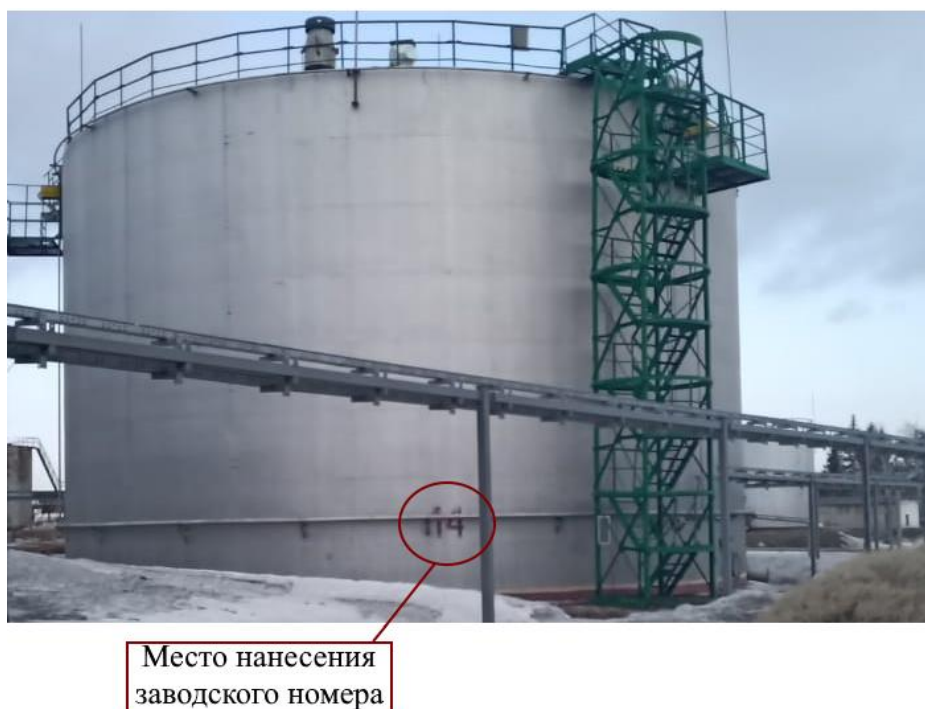
Рисунок 2 – Общий вид резервуара РВС-3000 №14 с указанием места нанесения заводского номера
