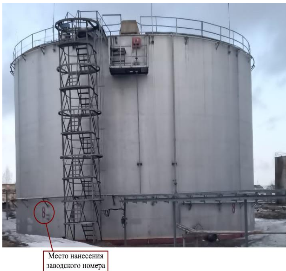
Рисунок 1 – Общий вид резервуара РВС-3000 №8 с указанием места нанесения заводского номера
