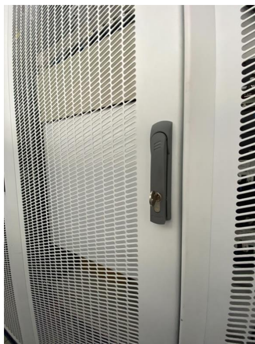
Рисунок 3 - Место блокировки от несанкционированного доступа к статавам с оборудованием
