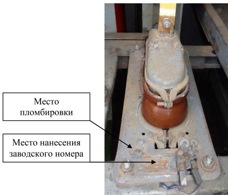
Рисунок 1. Общий вид средства измерений с указанием места пломбировки, места нанесения заводского номера
