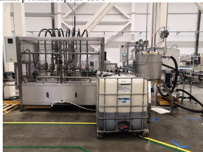
Рисунок 3 – Накопительные резервуары с жидкостью
