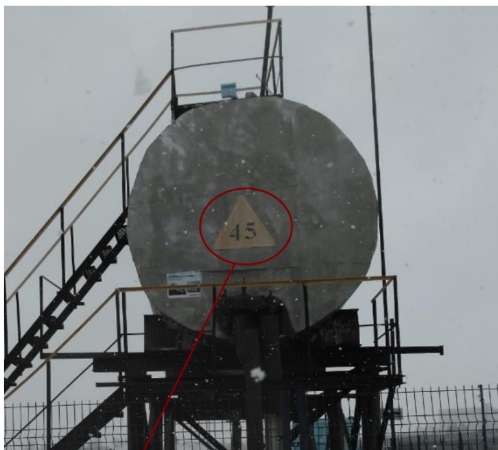
Рисунок 1 – Общий вид резервуара РГС-50 №33 с указанием места нанесения заводского номера
