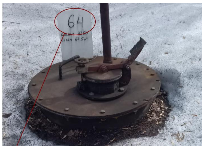
Рисунок 1 – Общий вид резервуара РГС-60 №63 с указанием места нанесения заводского номера
